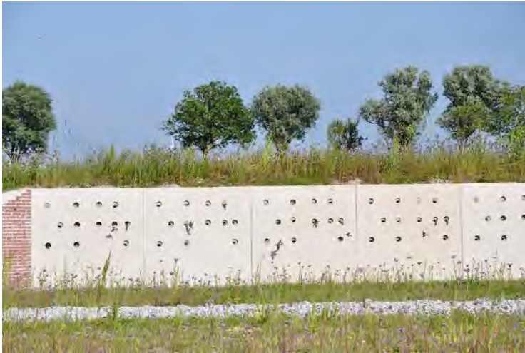
Een betonnen oeverwaluwwand in Deinum (foto Landschapsbeheer Friesland)
